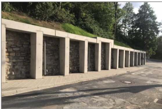
Stützwand an der Keilstraße. Bild: Norbert Konegen
